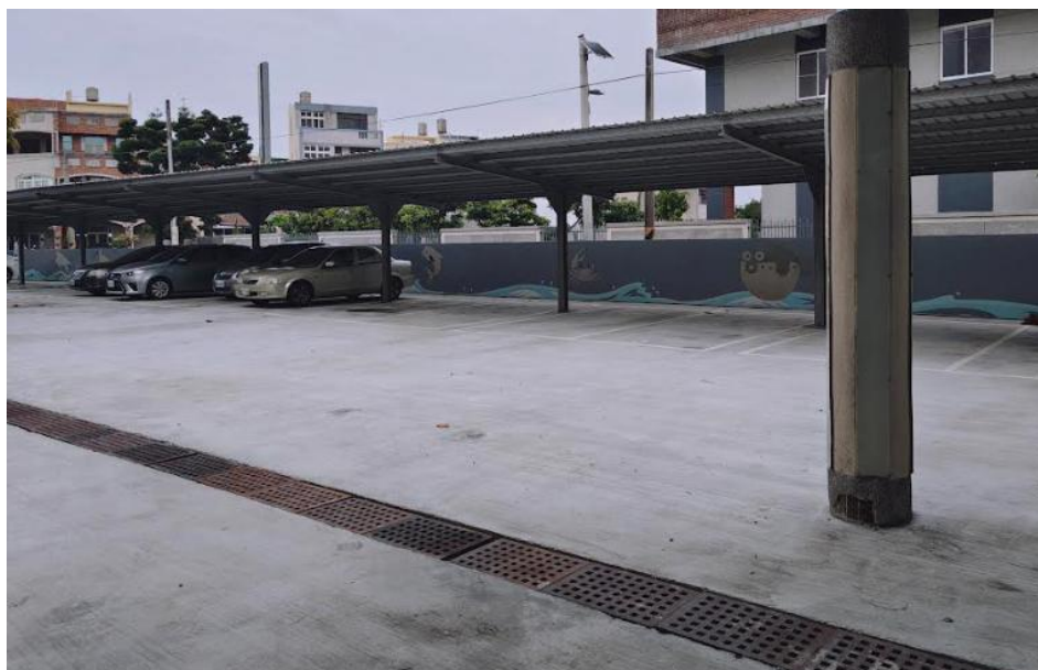
前停車場(東側圍牆)
