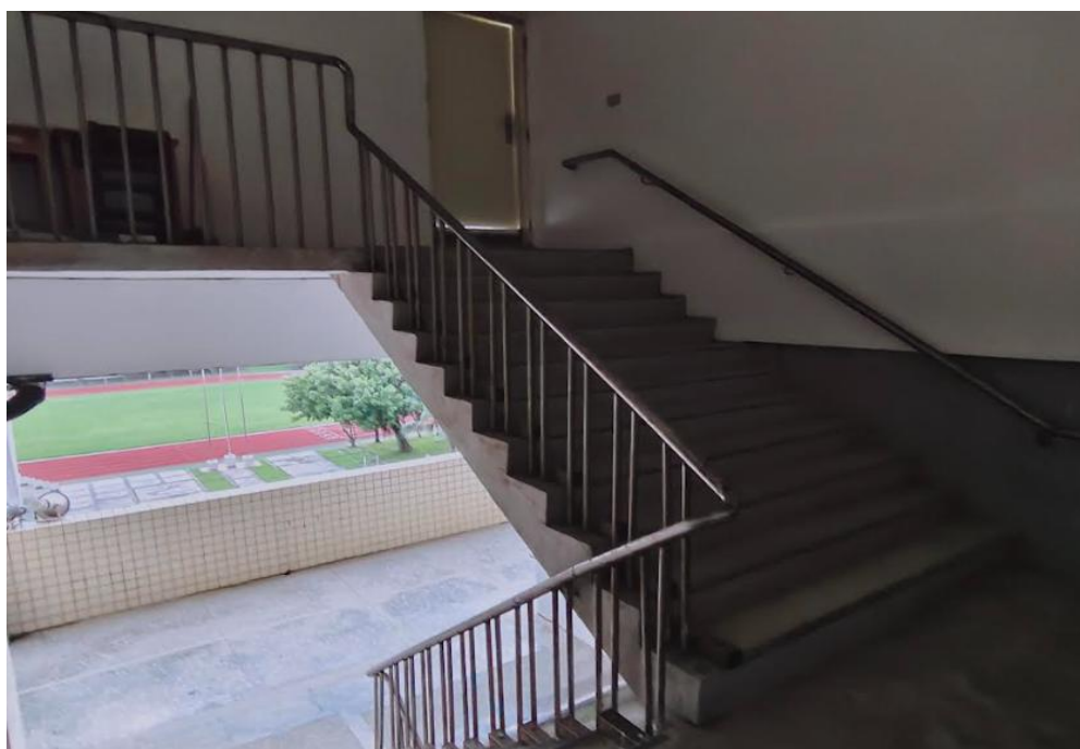
中間三樓到頂樓樓梯(轉角平台上方有監視器)
